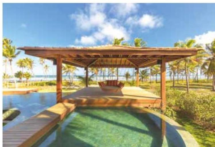
A estrutura é composta por: vigas, pilares e peças do telhado em madeira aparelhada tipo Pau d'arco e Cumarú. Lajes pré moldadas de concreto com eps . A cobertura em telha plana de concreto da marca Tégula na cor ocre grafitado.
